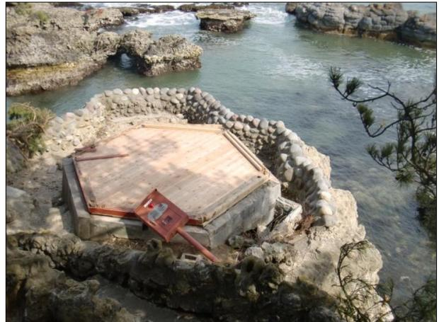
地震による津波で土台だけ残し流出
